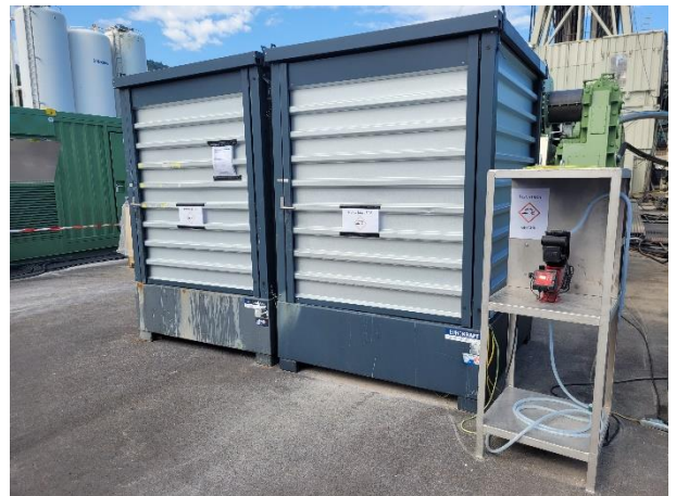
Système de la soude caustique débranché
