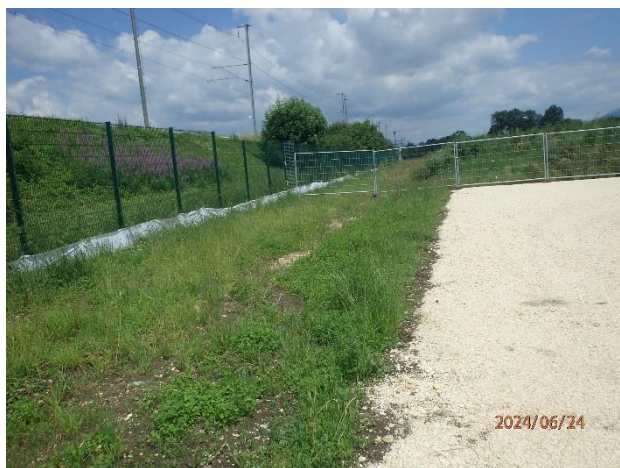
Figure 4-42 : Clôture autour du site et barrière à batraciens provisoire
