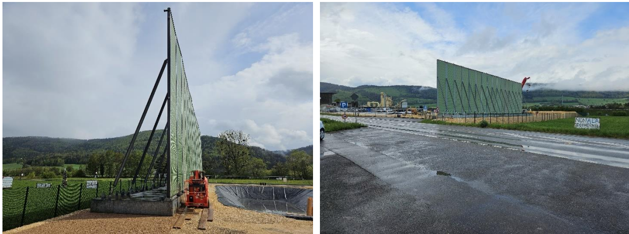
Figure 4-5 : Paroi antibruit en cours de construction en limite Est du site (17 avril 2024)
