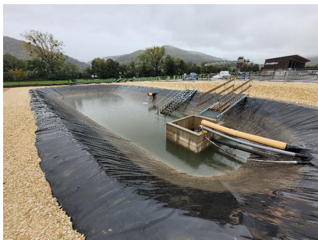
Figure 4-24 : Bassin de sécurité avec système de pompage et trop-plein vers les eaux usées (08.10.2024)
