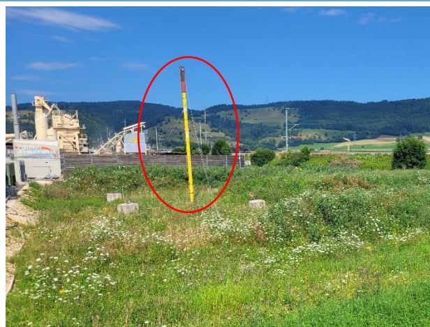
Figure 4-2 : Torchère mise en place pour prévenir le dégagement de gaz du sous-sol dans l'atmosphère.
