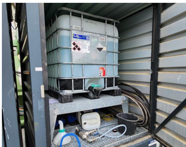
Figure 4-30 : Reserve de soude caustique - tuyau débranché et IBC fermé (30.07.2024)
