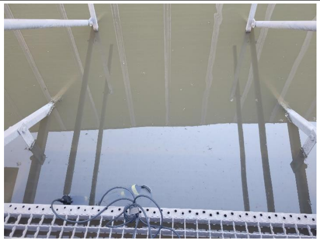
Bassin de sécurité : turbide avec fine particule à la surface
