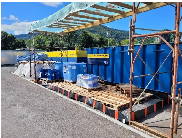
Produits chimiques sur bac de rétention
