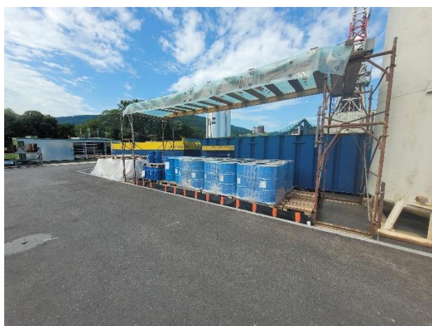
Figure 4-28 : Diverses substances nécessitant un stockage sur un bac de rétention (15.07.2024)
