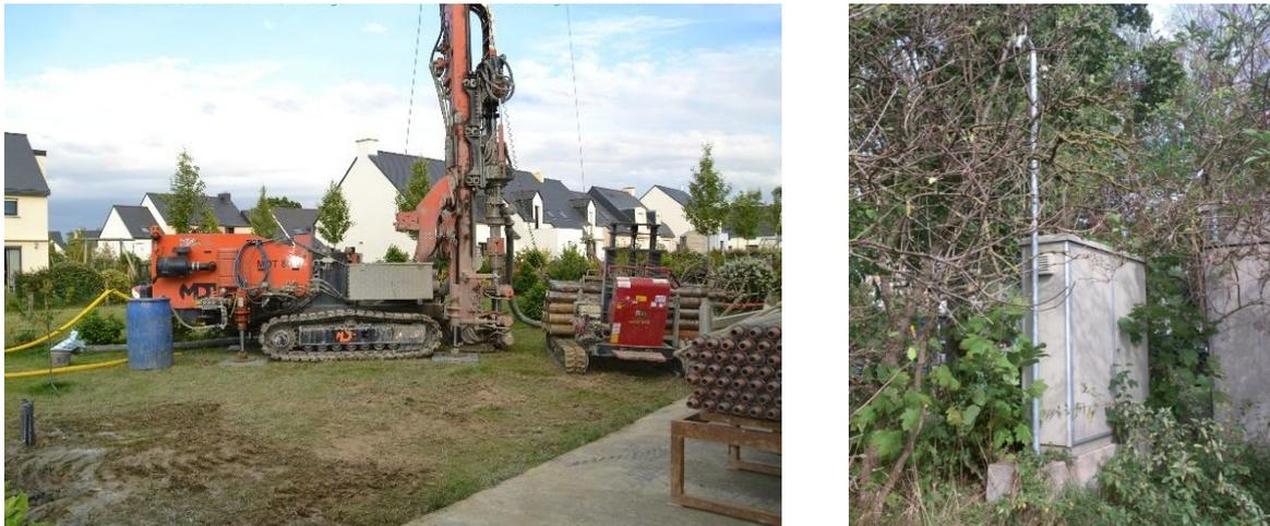
Figure 27 : A gauche, machine de forage pour la réalisation de sondes géothermiques pouvant servir à la réalisation du réseau de surveillance sismique. A droite, installation de surface contenant l'enregistreur et le système de transmission.
