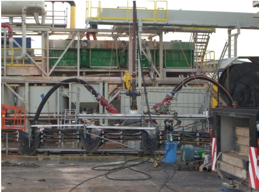
Figure 39 : Stimulation du forage Basel-1. Les tuyaux flexibles amenant l'eau sous pression dans le forage sont visibles sur la tête de puits.
