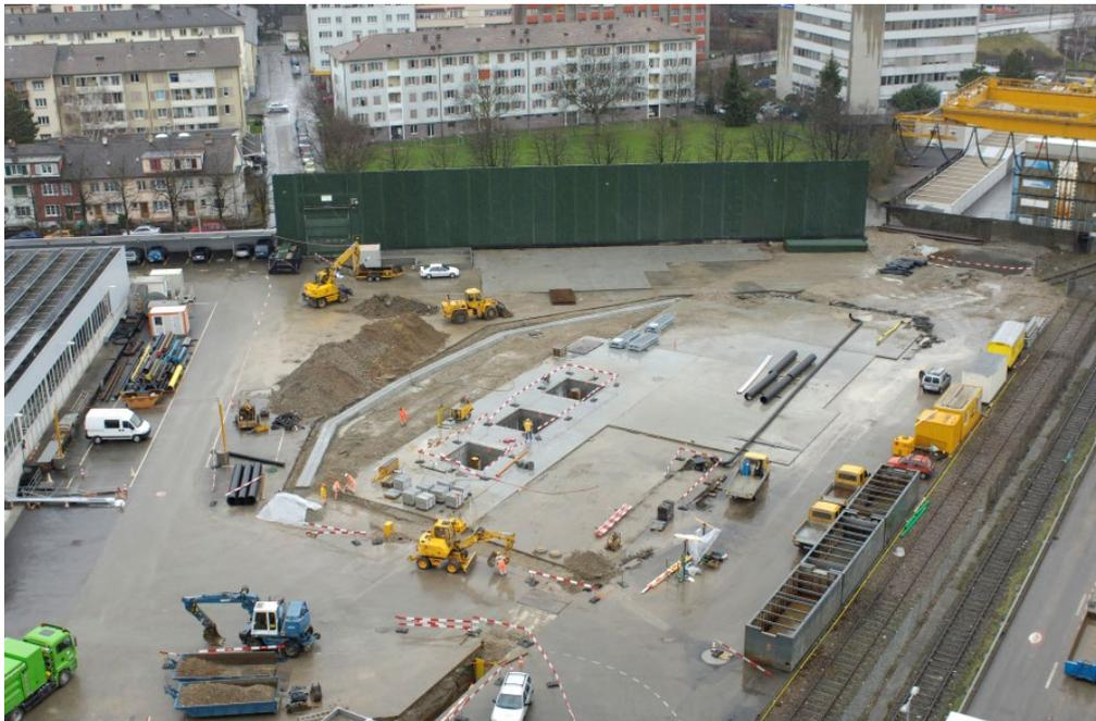
Figure 30 : Construction de la place de forage pour le projet de géothermie profonde DHM de Bâle. Au centre, les trois caves de forage sont visibles.
