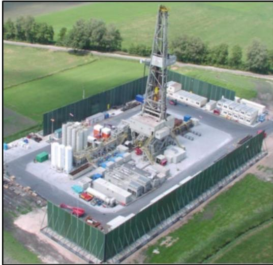
Figure 44 : exemple de paroi anti-bruit provisoire (Allemagne)
